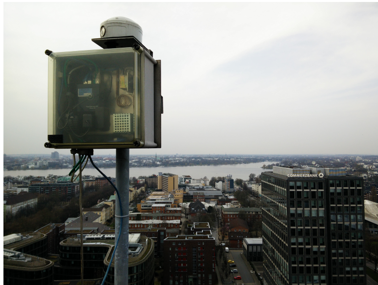
Abbildung 7.4.: Wetterfestes Gehäuse zur Unterbringung der Basisstation
