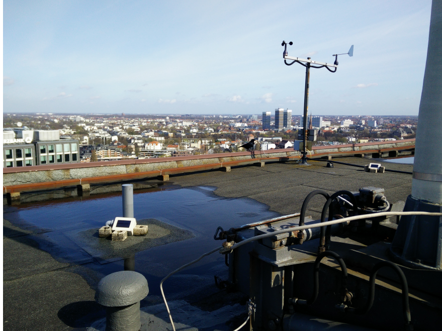
Abbildung 8.5.: Stehendes Wasser bei Box-4 nach einem Niederschlag
